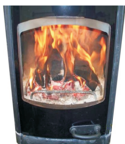
Fig. 5. Quand le feu est bien parti —réduire la commande d'arrivée d'air à 3
